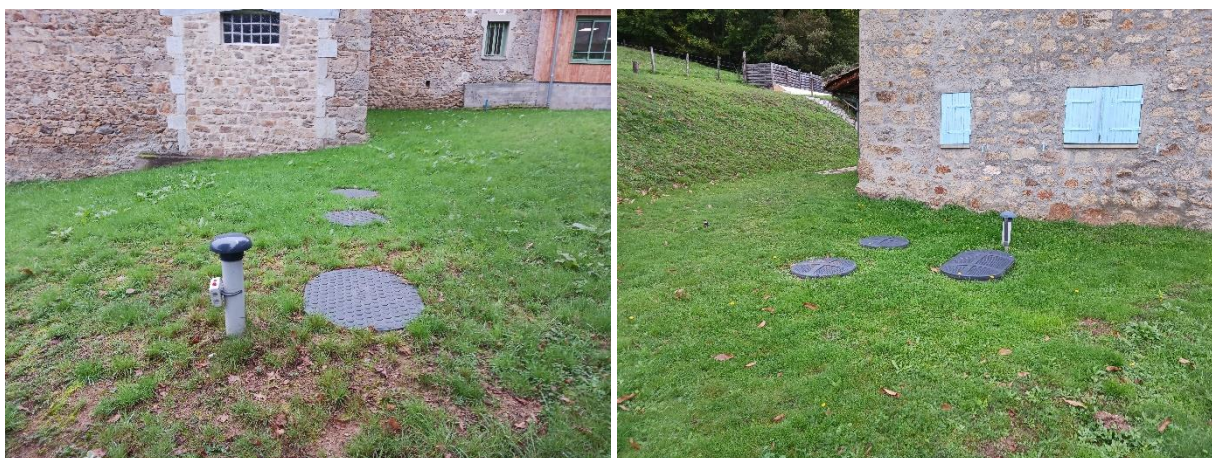
Installation d'assainissement non collectif de type filières compactes sur la commune de la Chapelle Agnon
